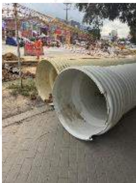
Ejecución contrato de obra No.126-2022
