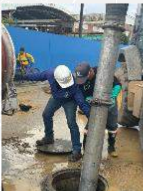
Limpeza pozos vehiculó de succión presión
