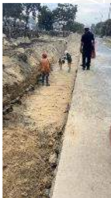
Ejecución contrato de obra No.126-2022
