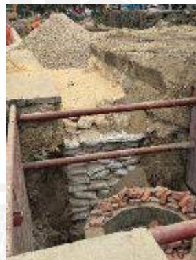
Ejecución contrato de obra No.126-2022
