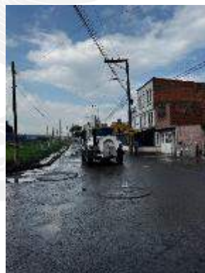
Limpeza pozos vehiculó de succión presión
