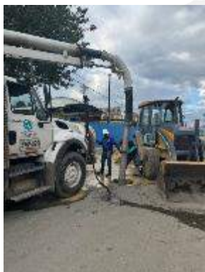
Limpeza pozos vehiculó de succión presión
